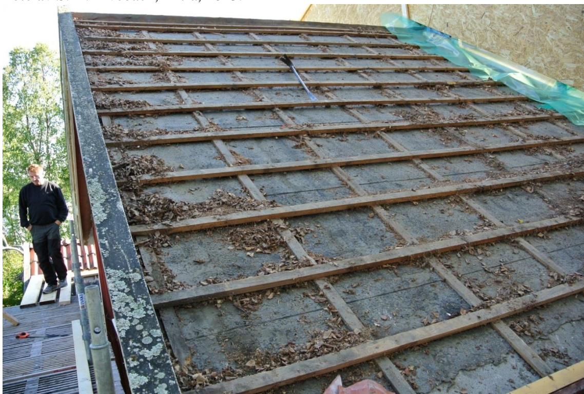
Bild 18 Doktorsgården, underlag till tegeltak med inblåsta löv. Foto av K. Markström, A-trä, 2013.
