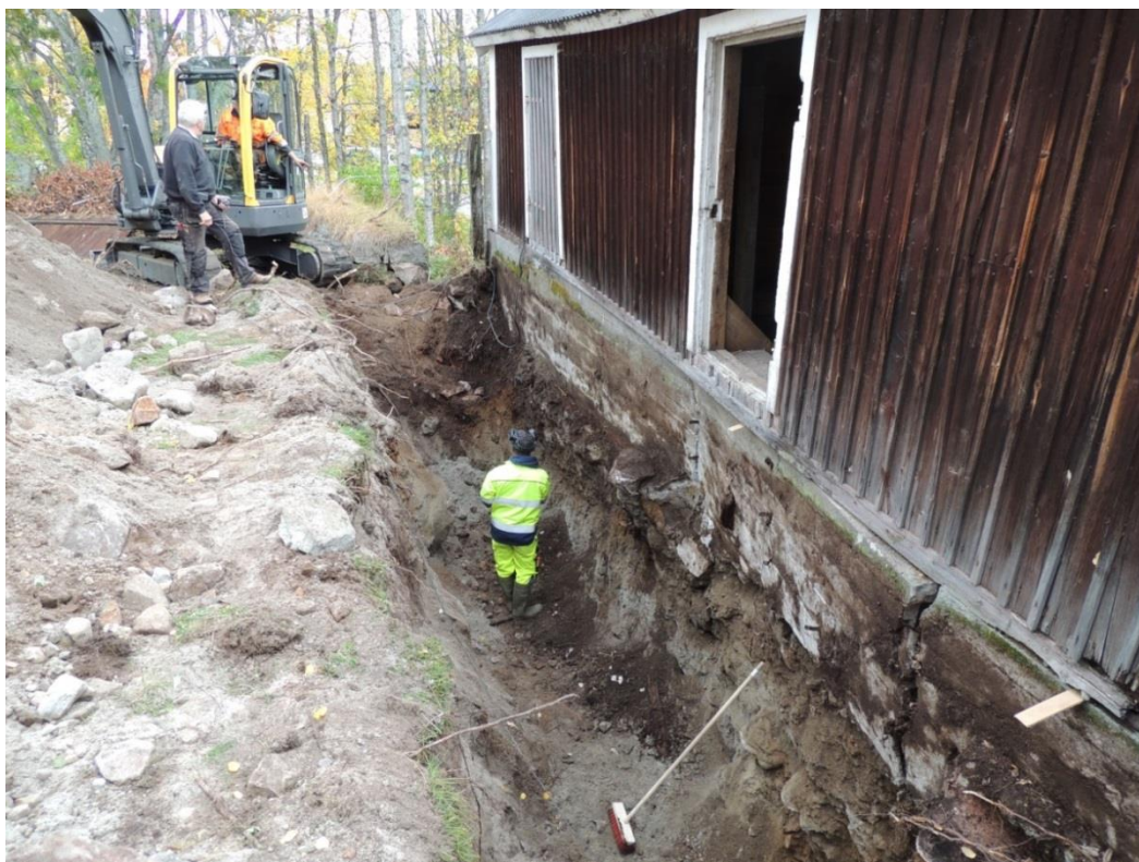
Bild 57 Stora uthuset, Doktorsgården, Utgrävning för dränering och gjutning. Foto av L. Liedgren, 2013.
