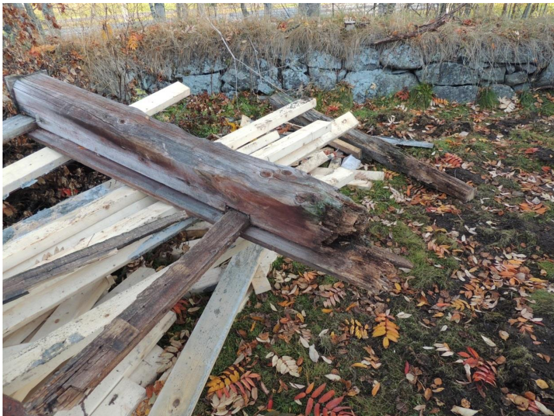
Bild 65 Ruttet bottenparti till stolpe, plank, Doktorsgården. Foto av L. Liedgren, 2013.
