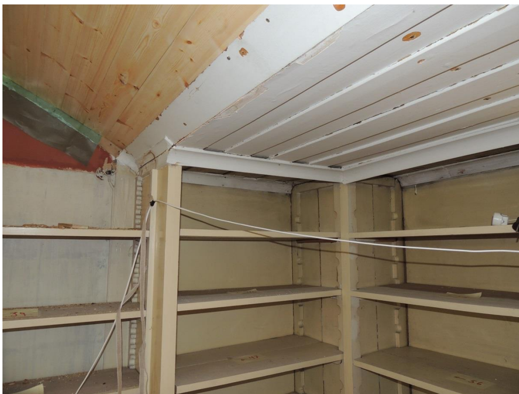
Bild 34 Doktorsgården, bostadshus, bibliotek, möte mellan ny och gammal inner-taksdel. Foto av L. Liedgren, 2013.
