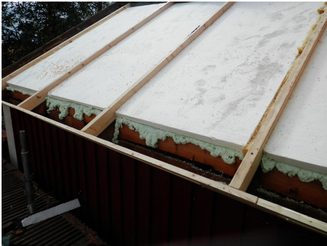
Bild 28 Doktorsgården, bostadshus, insättning av ny isolering i form av fogsium, frigolit och luftspalt. Foto av S.-E. Elveback, A-trä, 2013.
