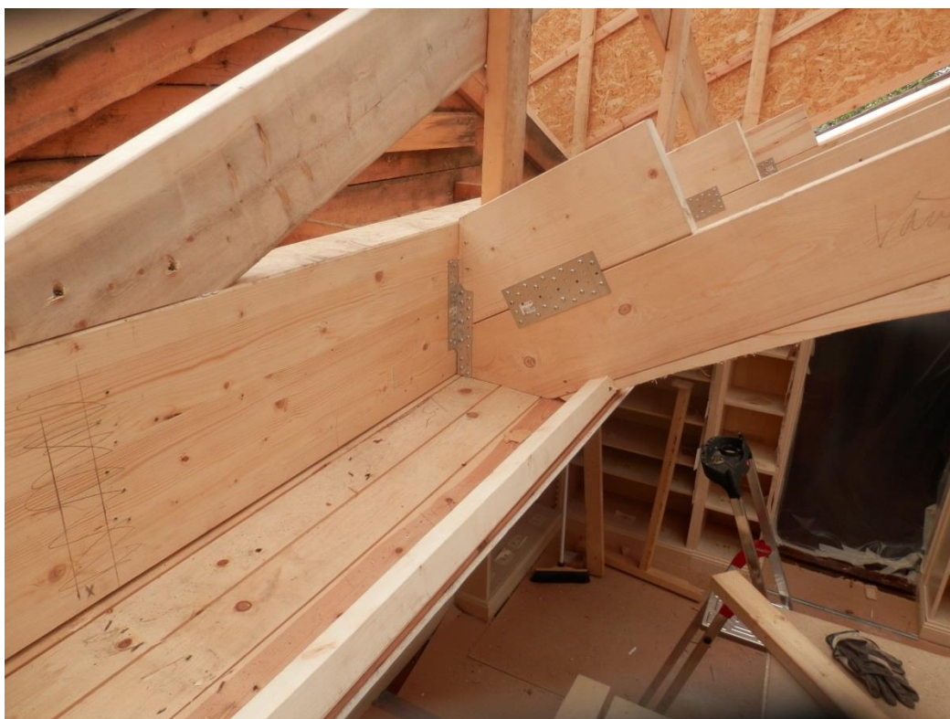
Bild 26 Doktorsgården, bostadshus, förstärkning med limbalkar i biblioteksdel. Foto av S.-E. Elveback, A-trä, 2013.
