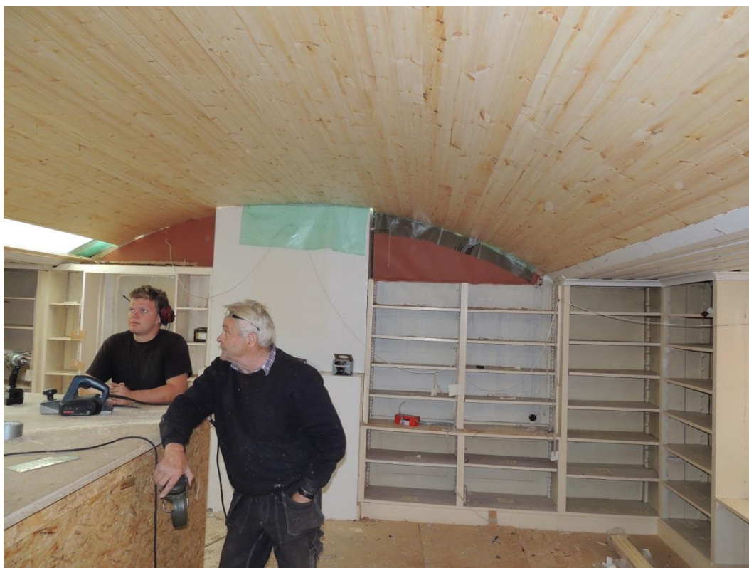
Bild 33 Doktorsgården, bostadshus bibliotek, insatt nytt innertak. På bild är S-E Elveback och Joel Wikström (A-trä). Foto av L. Liedgren, 2013.
