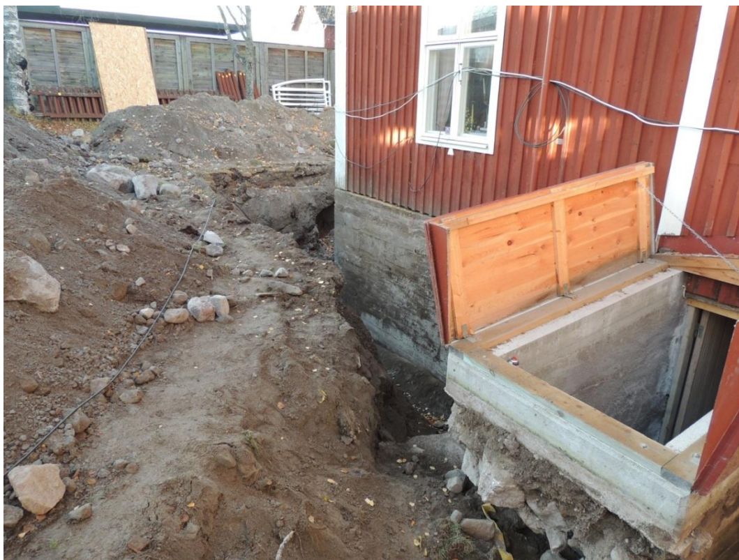
Bild 39 Doktorsgården, grävning för dränering vid källarnedgång, bostadshus. Foto av L. Liedgren, 2013.
