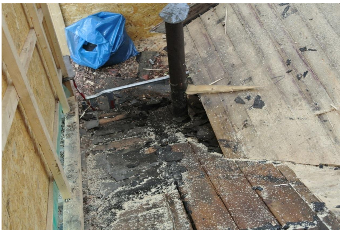
Bild 14 Doktorsgården, bostadshus, ventilationsrör och takpapp. Foto av K. Markström, A-trä, 2013.
