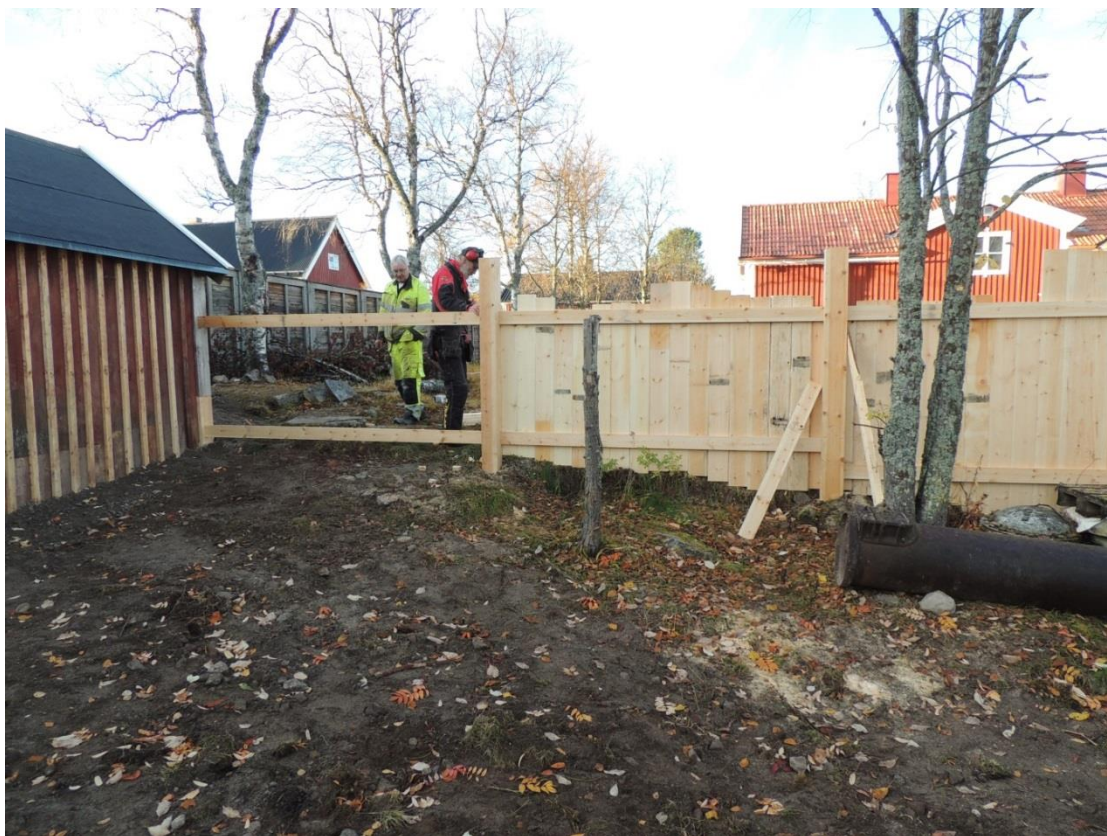
Bild 67 Uppsättning av nytt plank, Doktorsgården. Foto av L. Liedgren, 2013.
