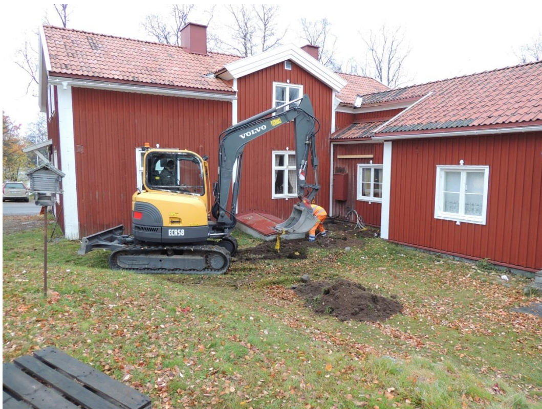
Bild 37 Doktorsgården, bostadshus, start utgrävning för dränering runt bostadshus. Foto av L. Liedgren, 2013.
