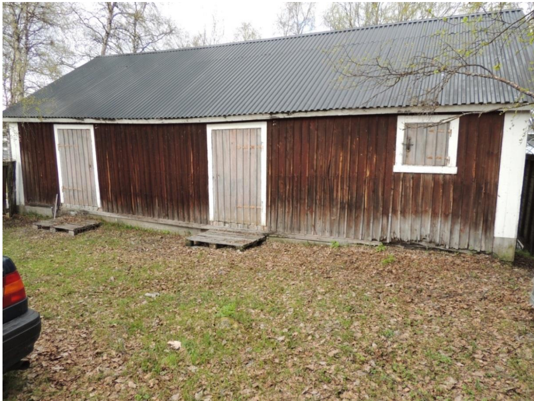
Bild 54 Stora uthuset, Doktorsgården, före upprustning, gårdssida. Foto av L. Liedgren, 2012.
