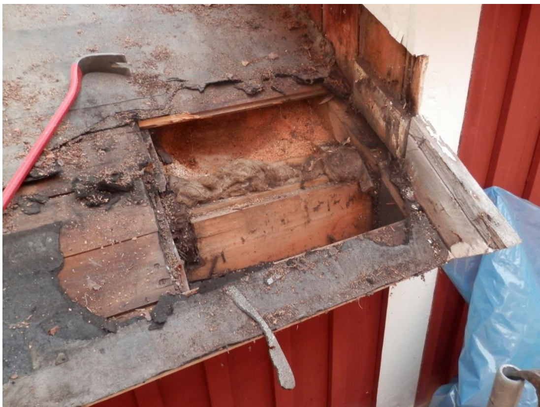
Bild 19 Doktorsgården, bostadshus, utbyggnad, troligen 1924, spontat grövre virke. Foto av S.-E. Elveback, A-trä, 2013.
