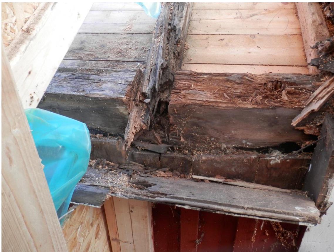
Bild 17 Doktorsgården, bostadshus, exempel på ruttet timmer i takslut vid rännal. Foto av S.-E. Elveback, A-trä, 2013.
