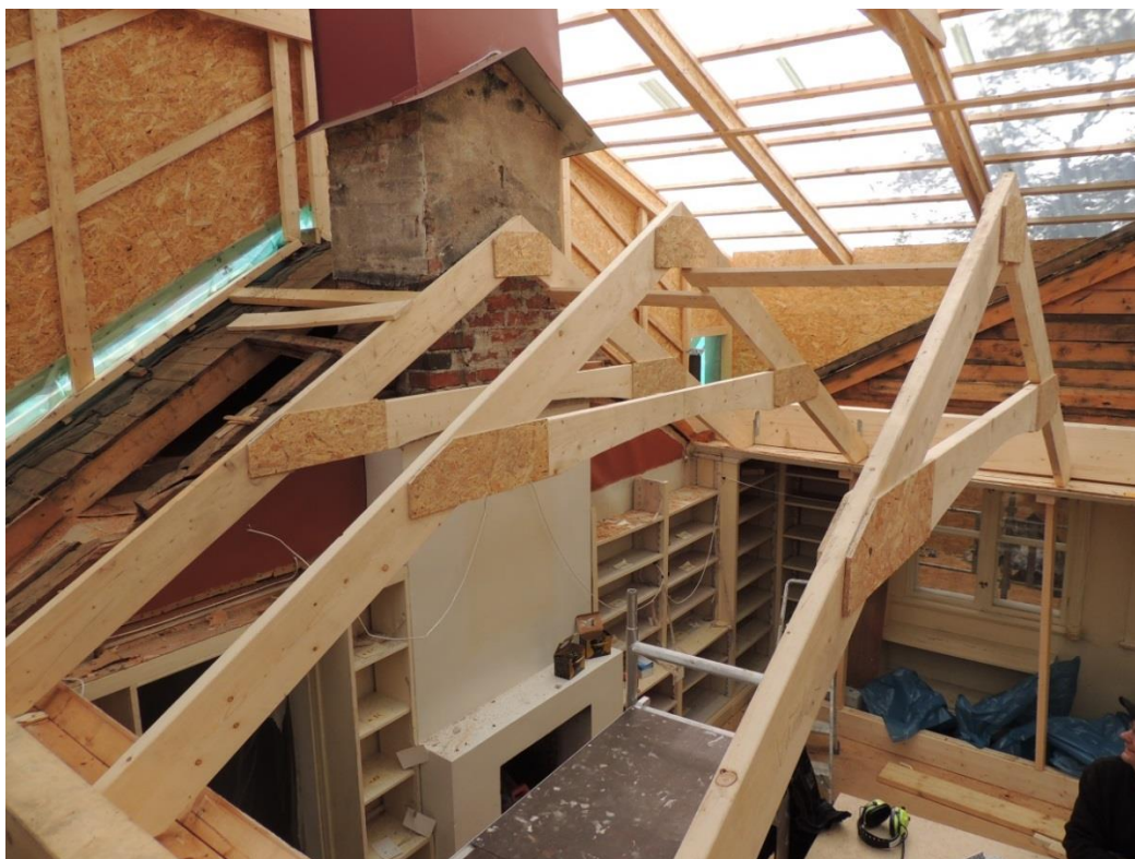
Bild 25 Doktorsgården, bostadshus, nya takbjälkar insatta över biblioteksdelen. I borte delen grövre balk för takstöd. Tvärsålar på balkar urtagna för innertak. Foto av L. Liedgren, 2013.
