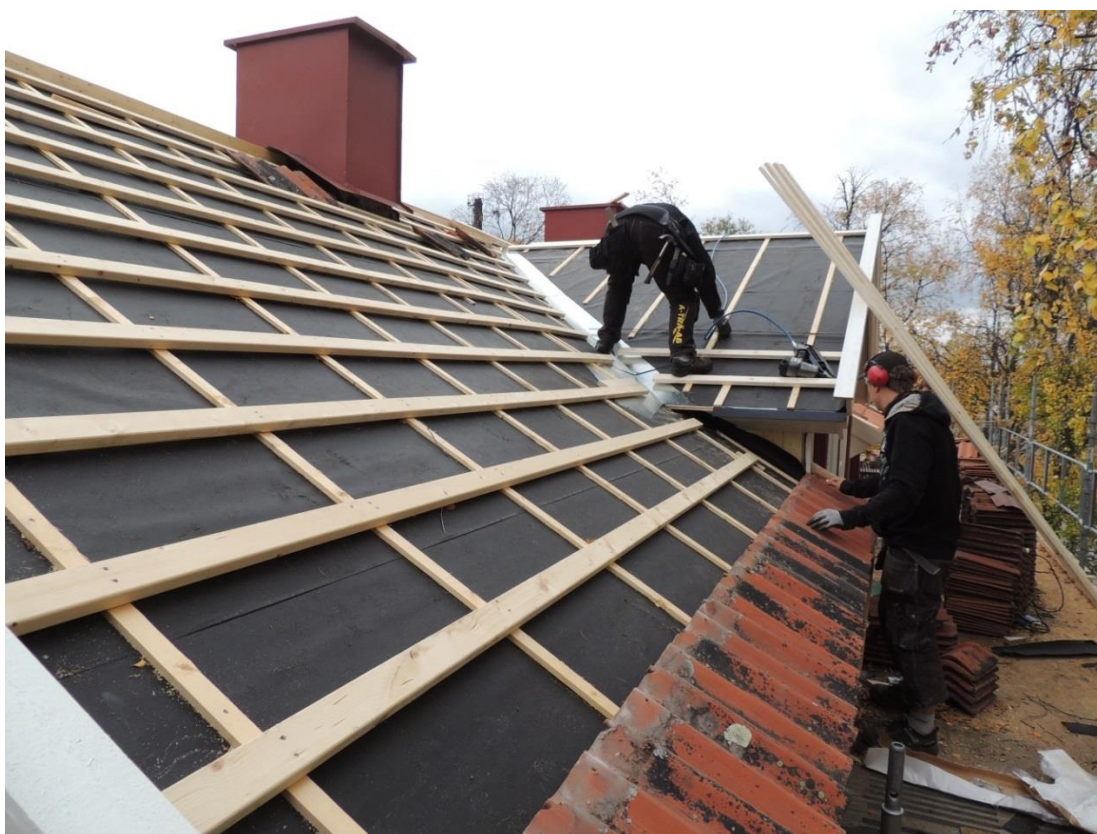
Bild 30 Doktorsgården, bostadshus, tegelläggning påbörjad ovanpå ny läkt. På bild är Tony Vesterlund och Dan Hallnor. Foto av L. Liedgren, 2013.
