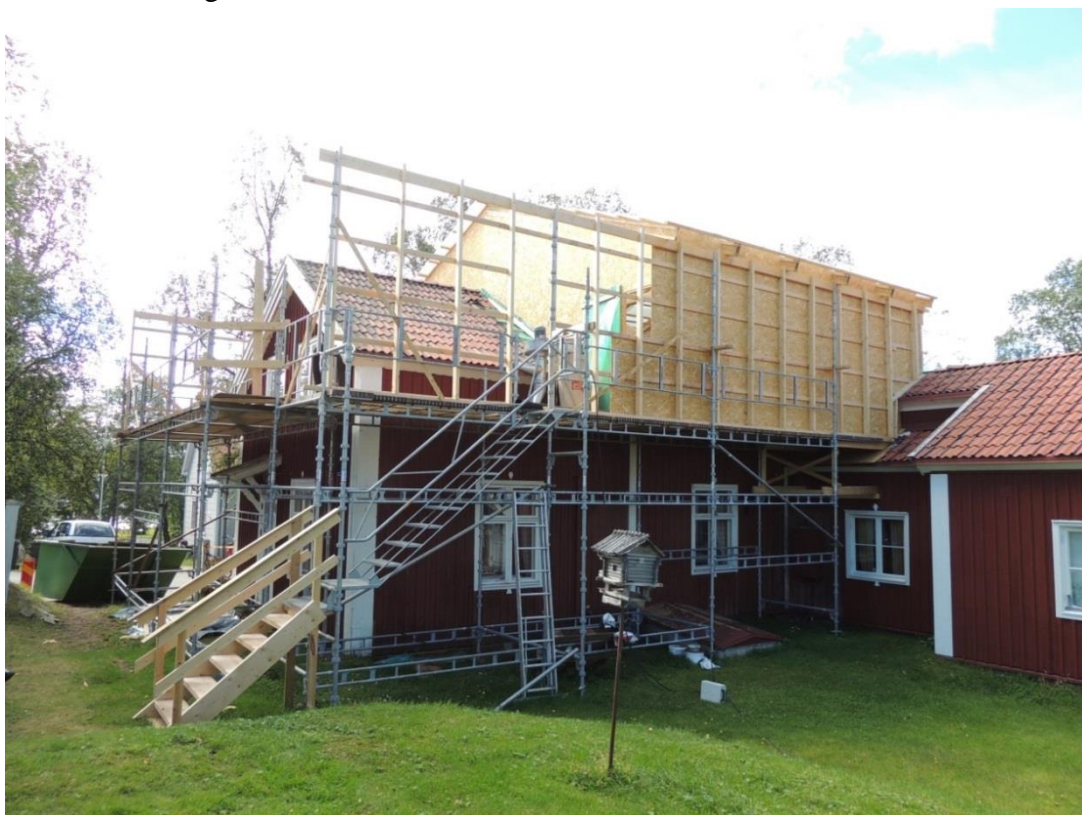
Bild 11 Doktorsgården, bostadshus, uppsättning av skyddstak över biblioteksdel. Foto av L. Liedgren, 2013.
