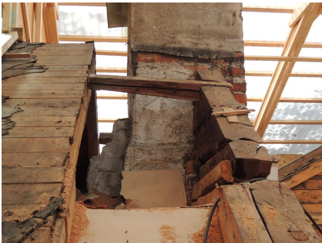
Bild 23 Doktorsgården, bostadshus, bilden visar timmervägg och takutsprång från ursprunglig timrad byggnad. Foto av L. Liedgren, 2013.
