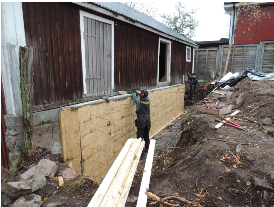
Bild 59 Stora uthuset, Doktorsgården, gjutning av betongförstärkning. Foto av L. Liedgren, 2013.
