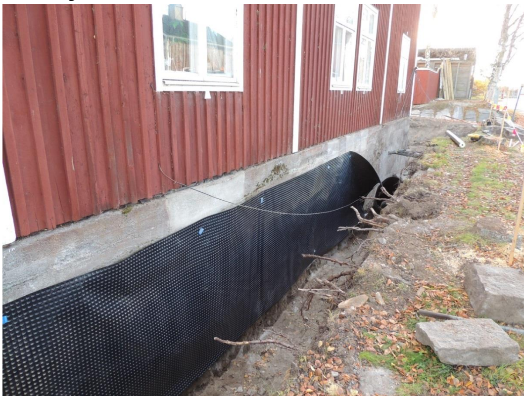
Bild 39 Doktorsgården, grävning för dränering vid källarnedgång, bostadshus. Foto av L. Liedgren, 2013.
