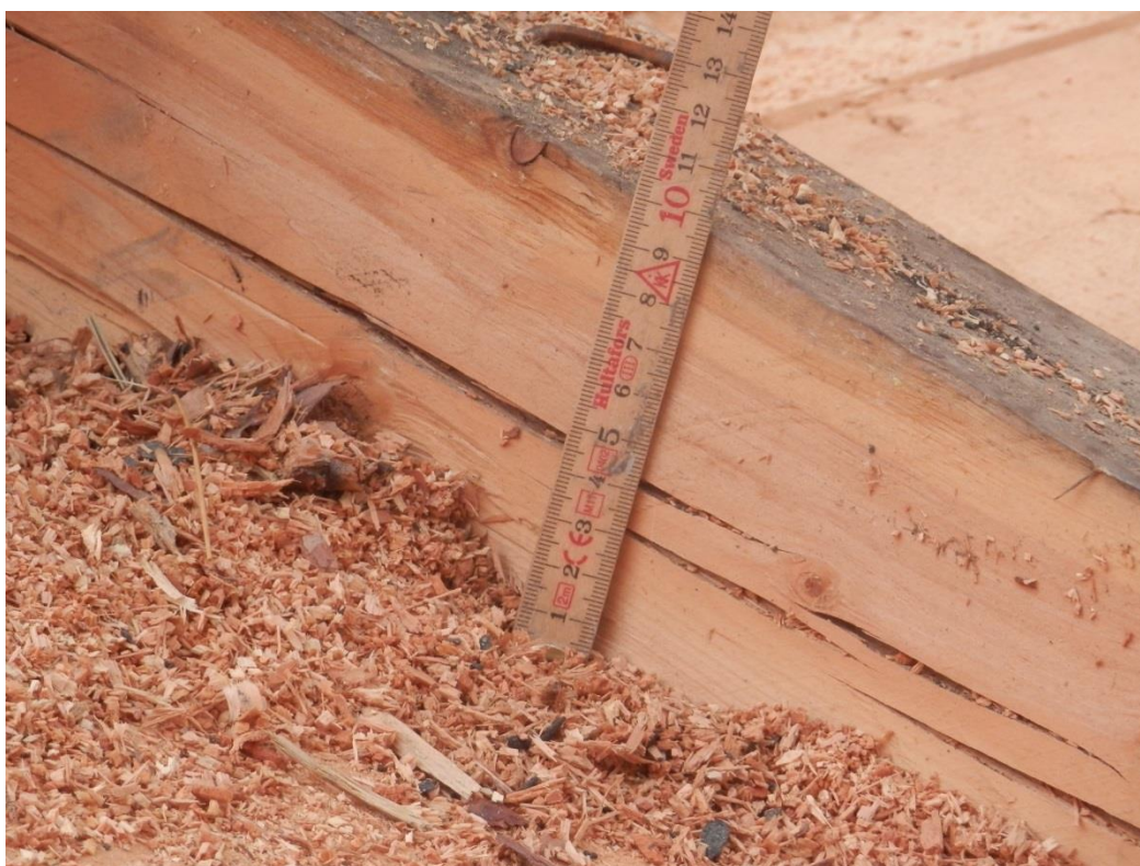
Bild 24 Doktorsgården, bostadshus, isolering under tak var mycket begränsad. Foto av S.-E. Elveback, A-trä, 2013.
