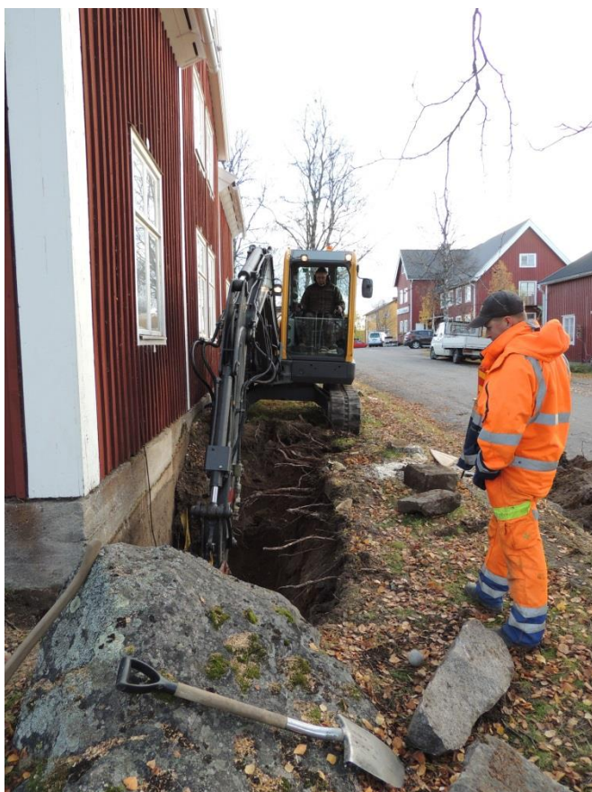
Bild 37 Doktorsgården, bostadshus, start utgrävning för dränering runt bostadshus. Foto av L. Liedgren, 2013.
