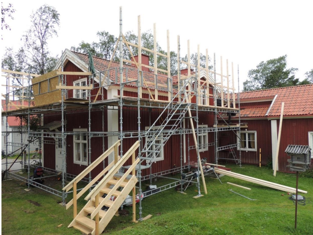
Bild 11 Doktorsgården, bostadshus, uppsättning av skyddstak över biblioteksdel. Foto av L. Liedgren, 2013.
