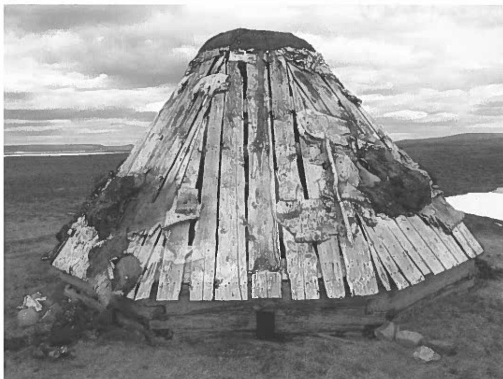
Bild 4 Takparti av Vuorekkåtan, före upprustning. Foto av M. Johansson, 2005.
