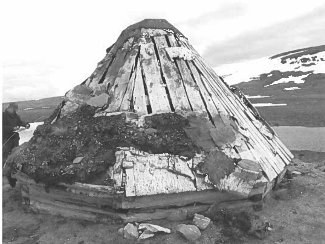
Bild 3 Takparti av Vuorekkåtan, före upprustning, till vänster är L. Liedgren. Foto av M. Johansson, 2005.
