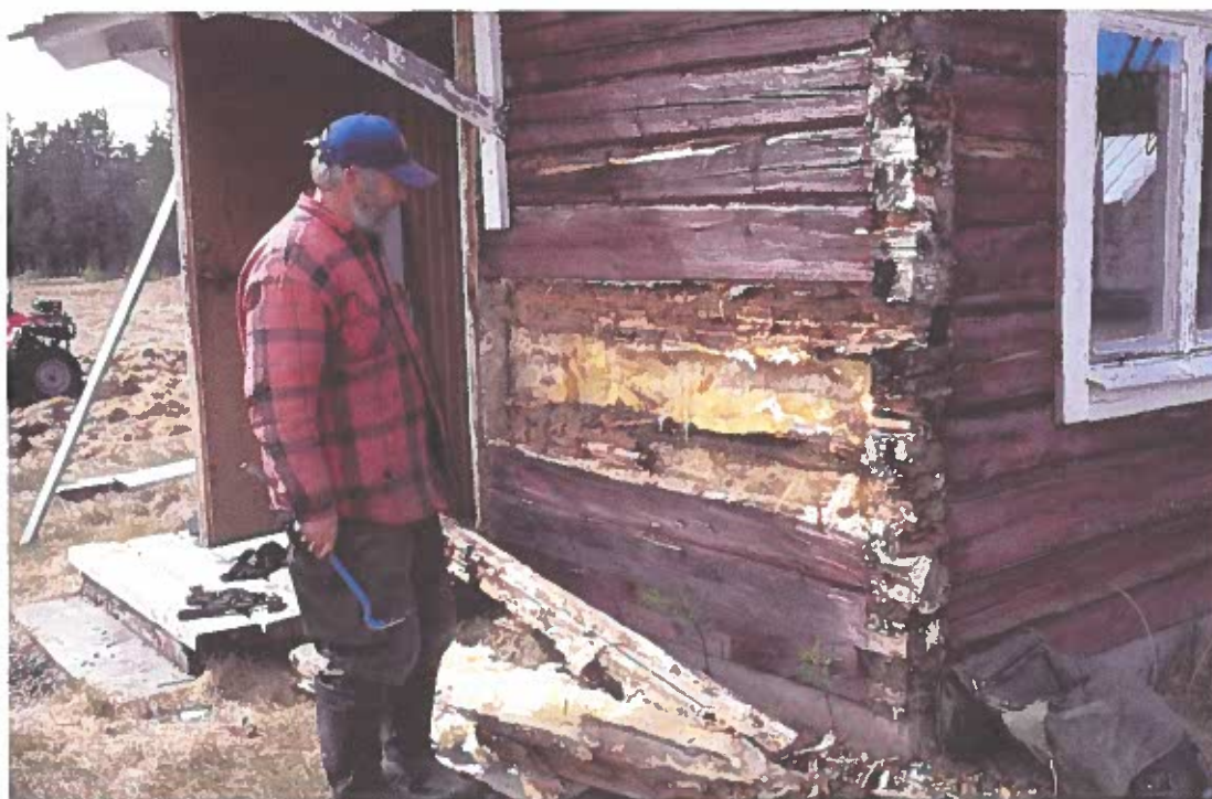
Bild 1 Udden, upprutnat virke i NÖ knuten. På bild är Ola Persson (Arjeplog). Foto av L. Liedgren, 2004, fr NÖ.
