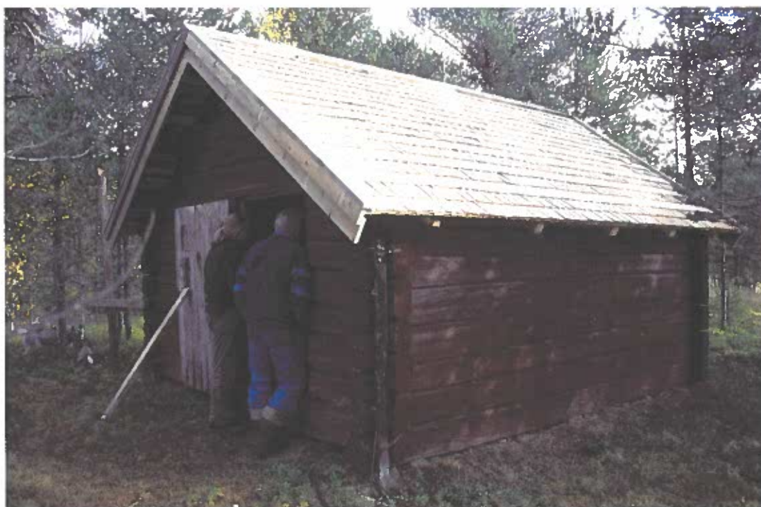
Bild 3 Suobdek, sommarladugård (byggnad G), upprustad med nytt spåntak. Foto av L. Liedgren, 2003.
