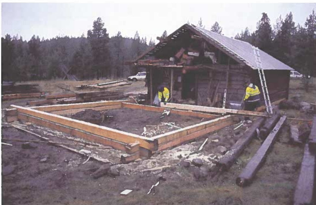
Bild 5 Suobdek, ladugård under uppbyggnad med nytt timmer. Foto av L. Liedgren, 2005.
