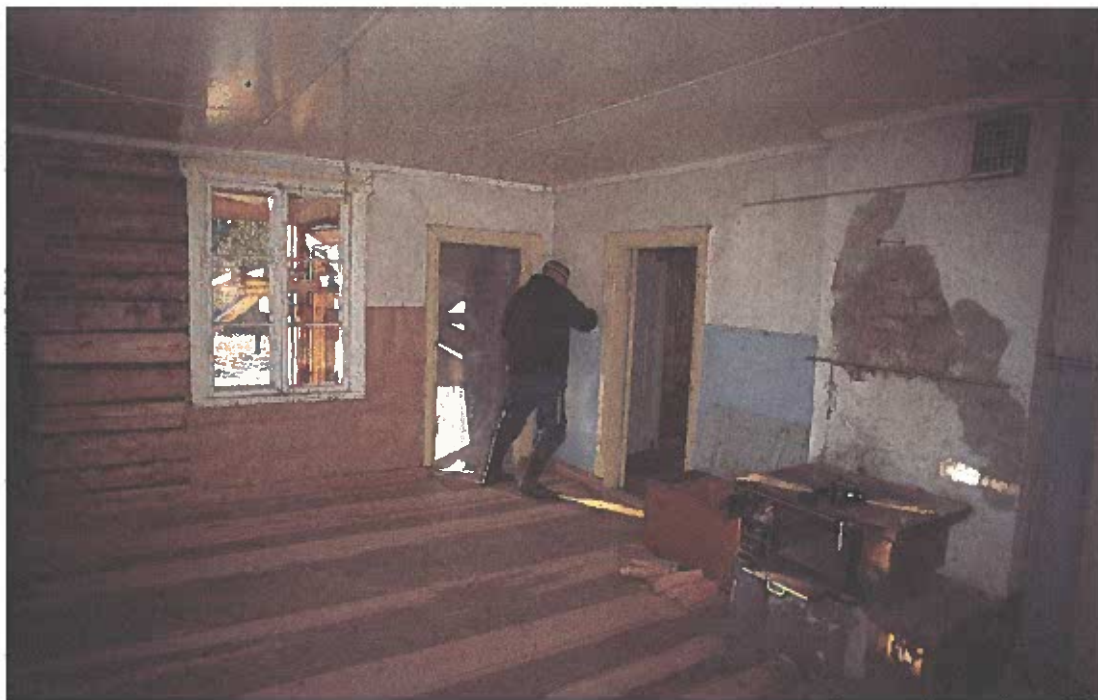
Bild 8 Suobdek, mangårdsbyggnad, kök, nedrivning av väggbeklädnad. Foto av L. Liedgren, 2003.
