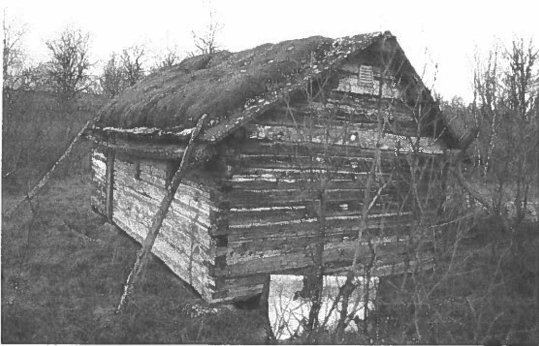
Bild 4 Timrad stuga vid Arvassjön, före upprustning. Foto fr V av L. Liedgren, 2001.
