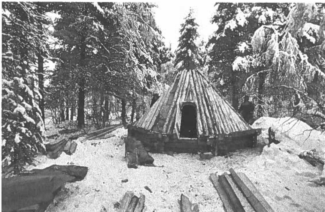
Bild 19 Uppsättning av åttkantig timrad kåta vid gamla nomadskolan, färdigt resultat. Foto av L. Liedgren, 2002.
