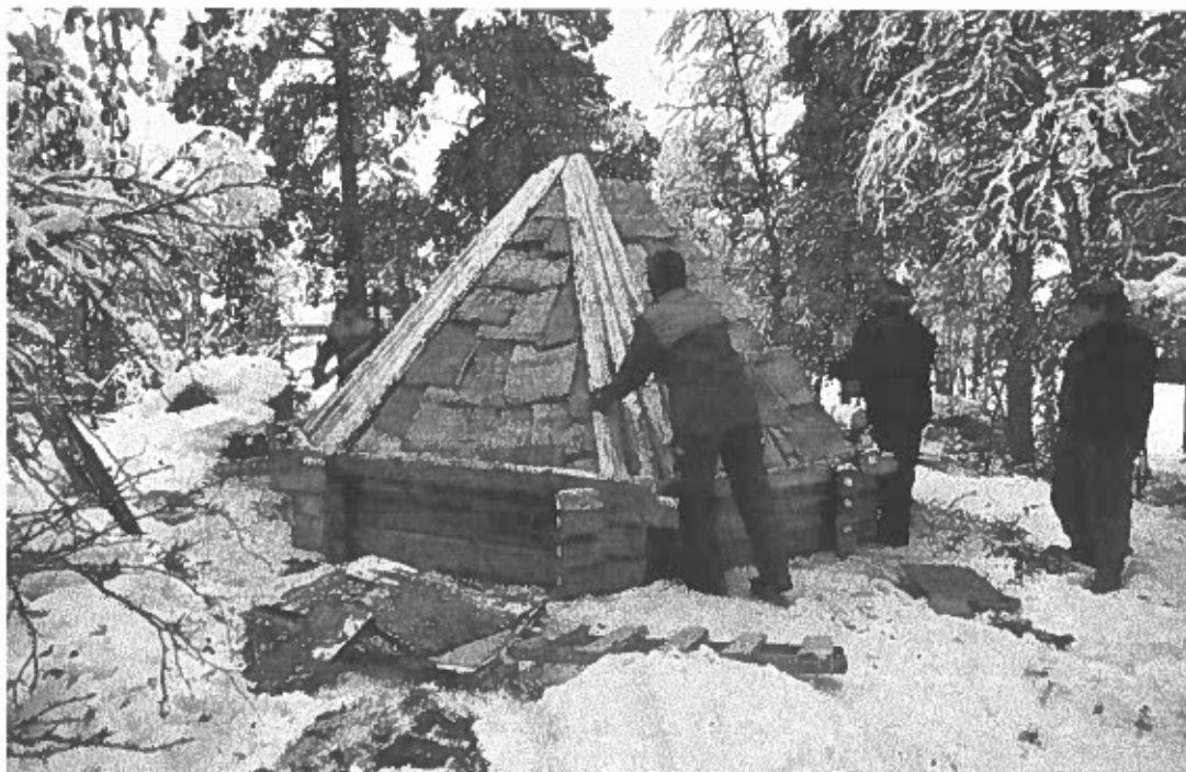
Bild 17 Uppsättning av åttkantig timrad kåta vid gamla nomadskolan, takläggning med näver och halvklover. Foto av L. Liedgren, 2002.
