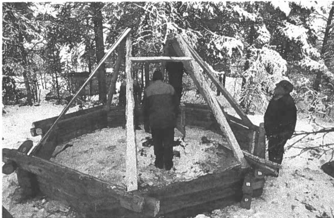
Bild 15 Uppsättning av åttkantig timrad kåta vid gamla nomadskolan. Foto av L. Liedgren, 2002.
