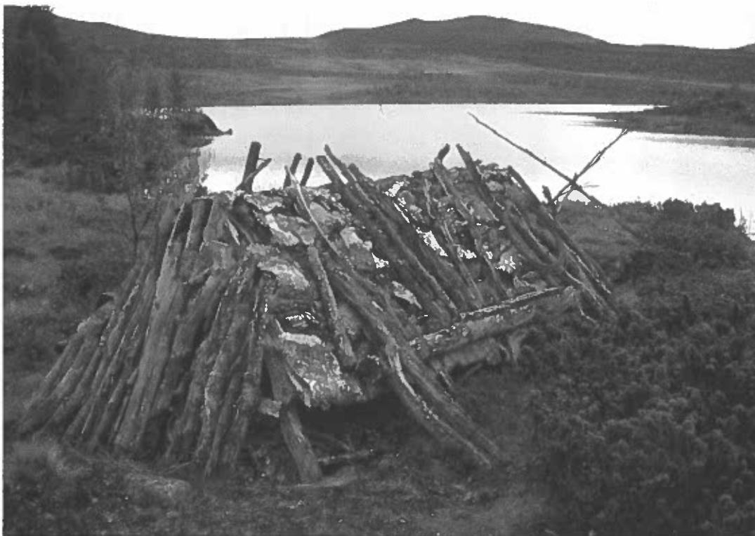
Bild 20 Båthus, Alep Rissájávrrre, före upprustning. Foto fr S av L. Liedgren, 1997.
