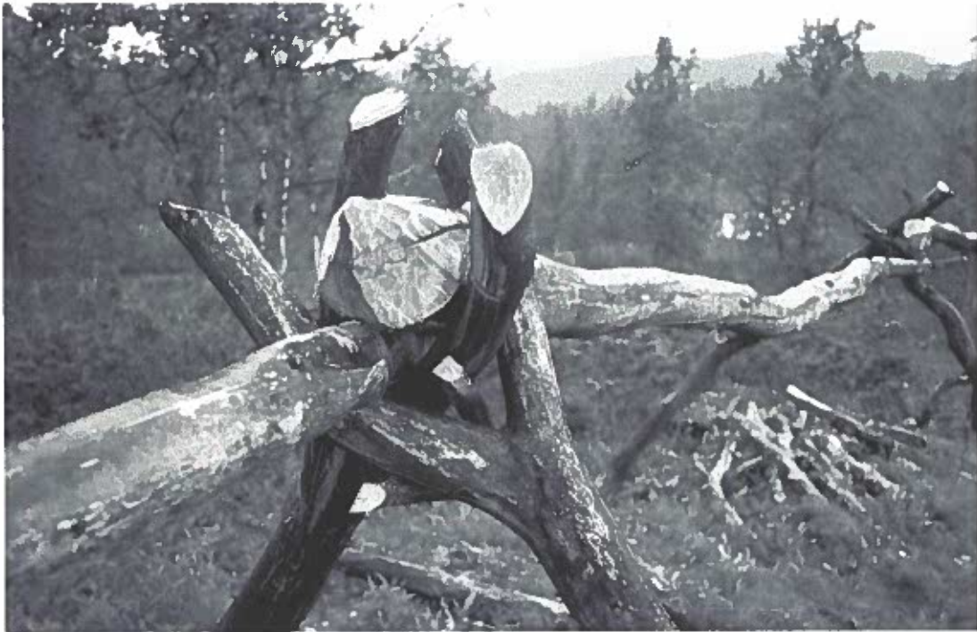
Bild 4 Klykstångskoppling vid upprustning av gärdan. Foto av L. Liedgren 2001.
