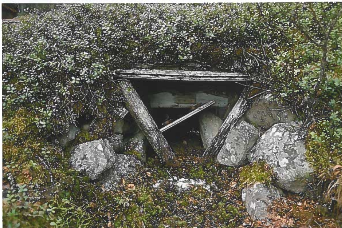
Fig. 7 Källare nr 5, före upprustning, Geijaure, Mausjaur sameby. Foto av L. Liedgren, 2001.
