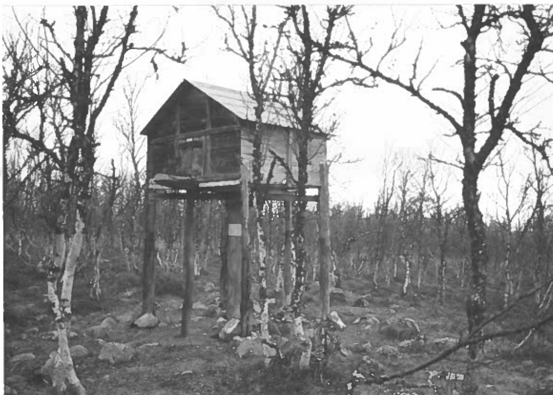
Fig 2 Njallan i Balgesnunnje, efter upprustning, nock saknas. Foto av L. Liedgren, 2000.
