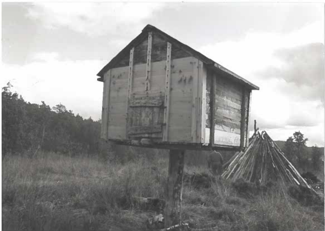
Bild 17 Njalla på plats i färdigt skick. Foto av L. Liedgren, 2000.
