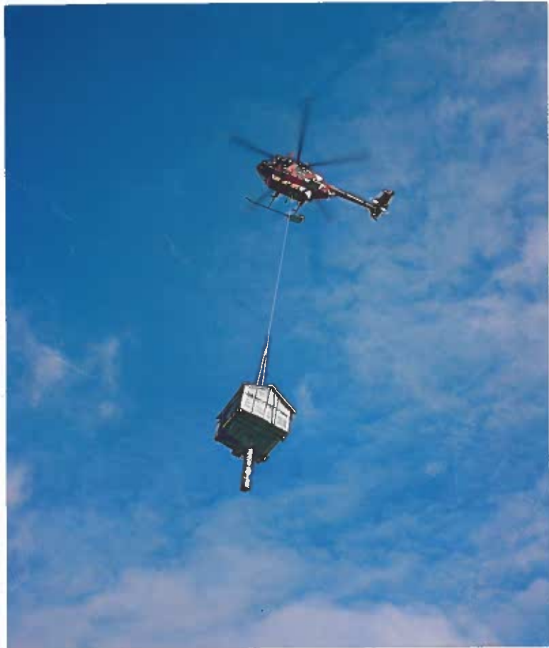
Bild 16 Njalla lyftes på plats med helikopter. Foto av L. Liedgren, 2000.
