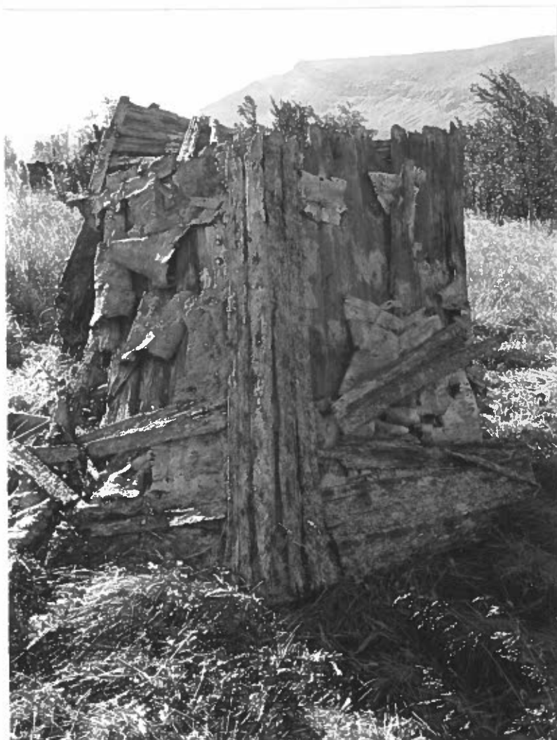
Bild 13 Njalla, takdel, före upprustning. Foto av L. Liedgren, 1999.
