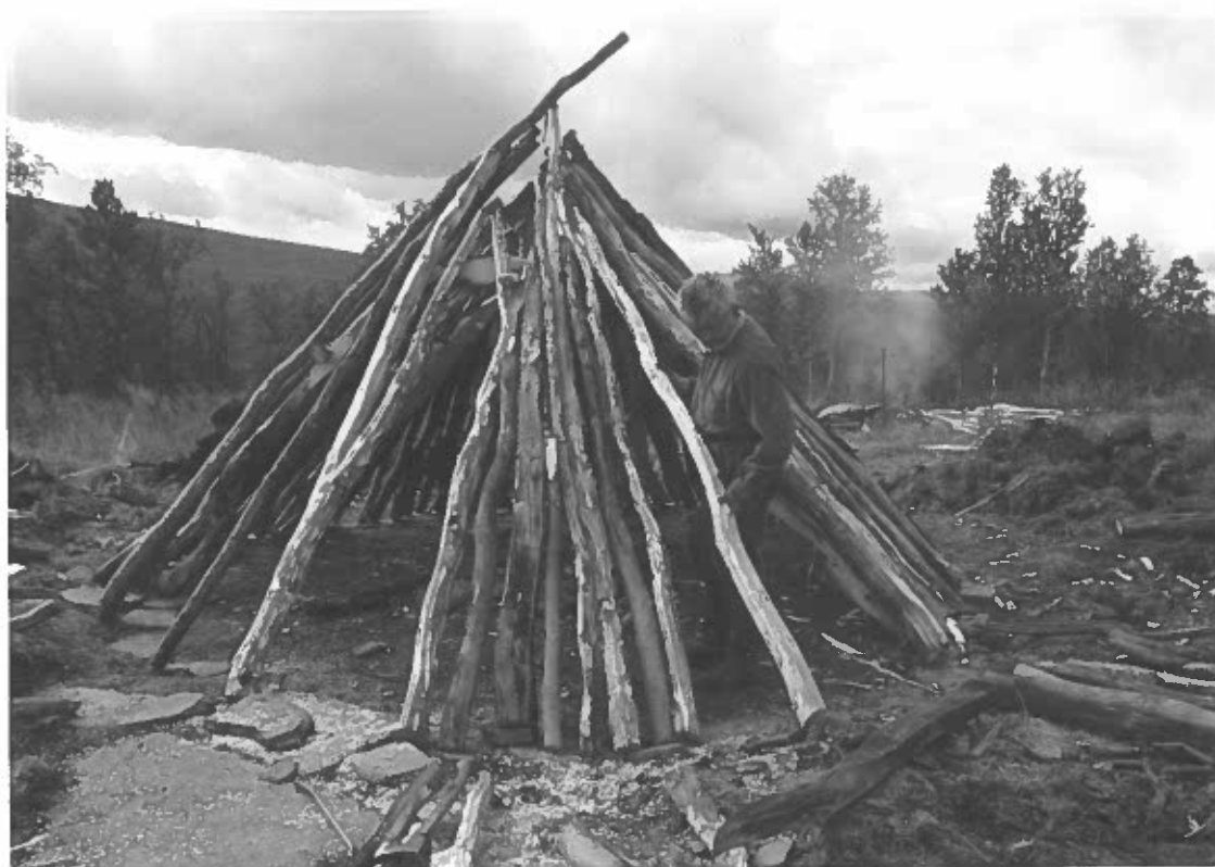
Bild 8 Torvkåta, inpassning av resvirke, på bild är S.-E. Elveback. Foto fr NÖ av L. Liedgren, 2000.
