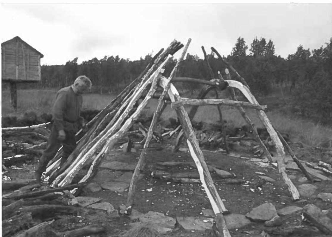
Bild 7 Torvkåta, upprustning, stomme samt delar av resvirke upprest, på bild är S.-E. Elveback. Foto fr SV, av L. Liedgren, 2000.
