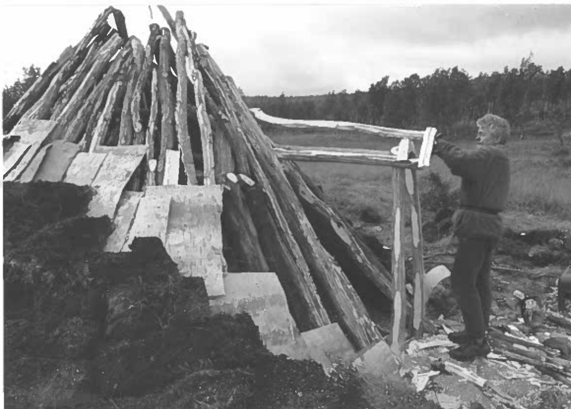
Bild 9 Torvkåta, arbete med stomme till farstu, på bild är S.-E. Elveback. Foto fr SSÖ av L. Liedgren, 2000.
