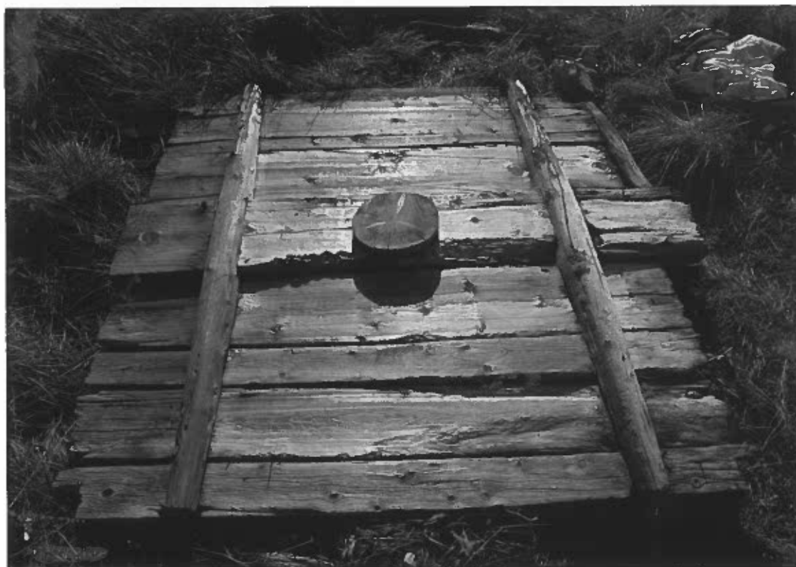
Bild 15 Njalla, golv, underifrån, före upprustning. Foto av L. Liedgren, 1999.
