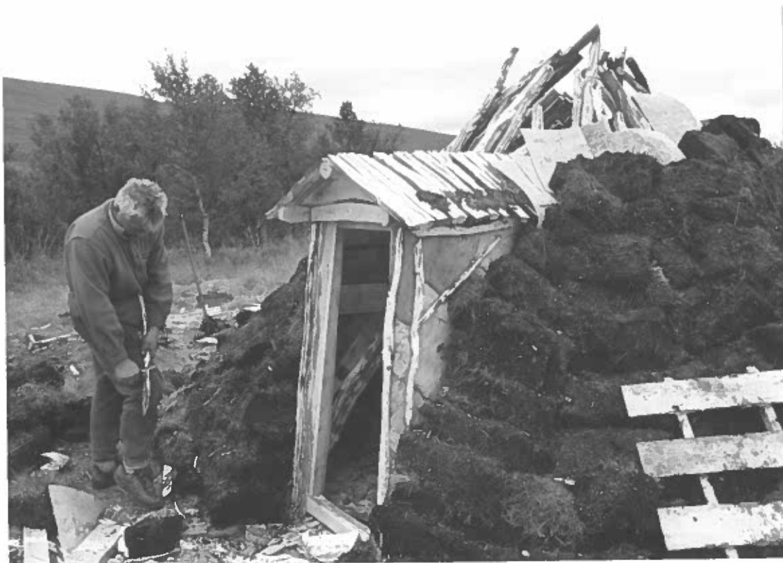
Bild 10 Torvkåta, Torvning av kåtan vid farstu, på bild är S.-E. Elveback. Foto av L. Liedgren, 2000.
