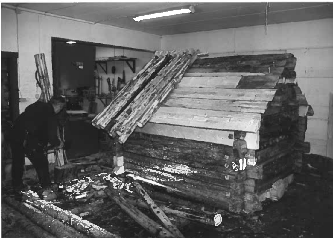
Bild 6 Skålka, restaurering av njalla, tillverkning av yttertak. Foto av L. Liedgren, 1999.
