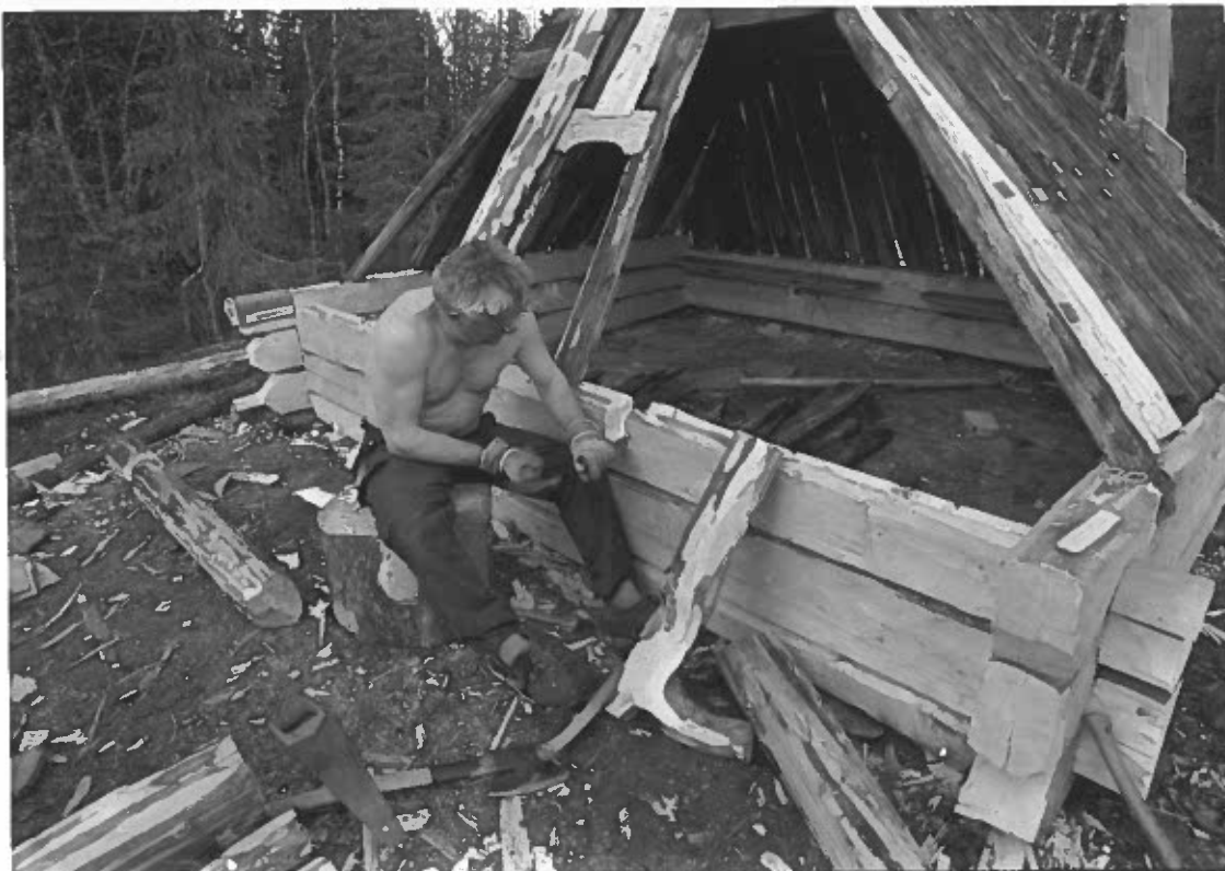
Bild 19 Skålka, kåta, upptagning av urtag för krokar vid dörrhål, på bild är S.-E. Elveback. Foto av L. Liedgren, 1999.
