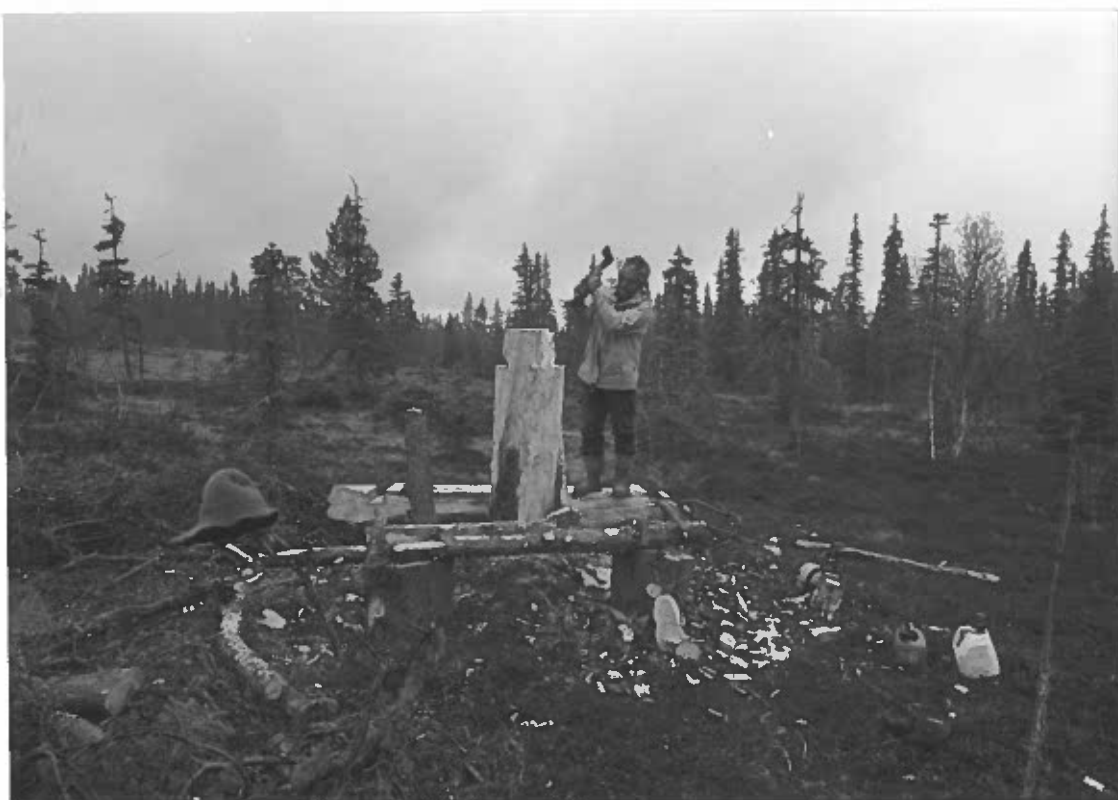
Bild 9 Skålka, huggning av tapp till njallastolpe, på bild är S.-E. Elveback. Foto av L. Liedgren, 1999.
