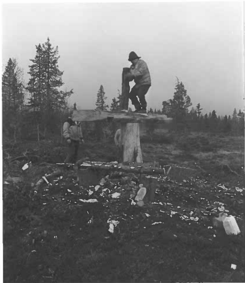
Bild 10 Skålka, inpassning av ny gietkam till njalla. Foto av L. Liedgren, 1999.
