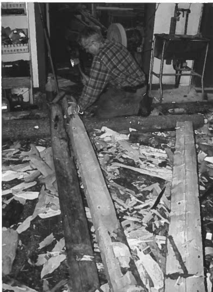
Bild 5 Skålka, restaurering av njalla, tillverkning av ny takfotsbräda, på bild är S.-E. Elveback. Foto av L. Liedgren, 1999.
