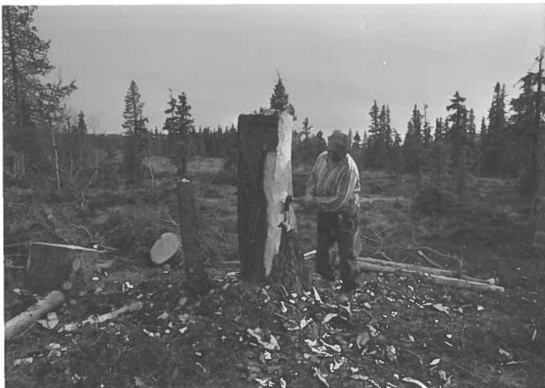
Bild 8 Skålka, barkning av rotstolpe till njalla med yxa, på bild är L.-E, Ruong. Foto av L. Liedgren, 1999.
