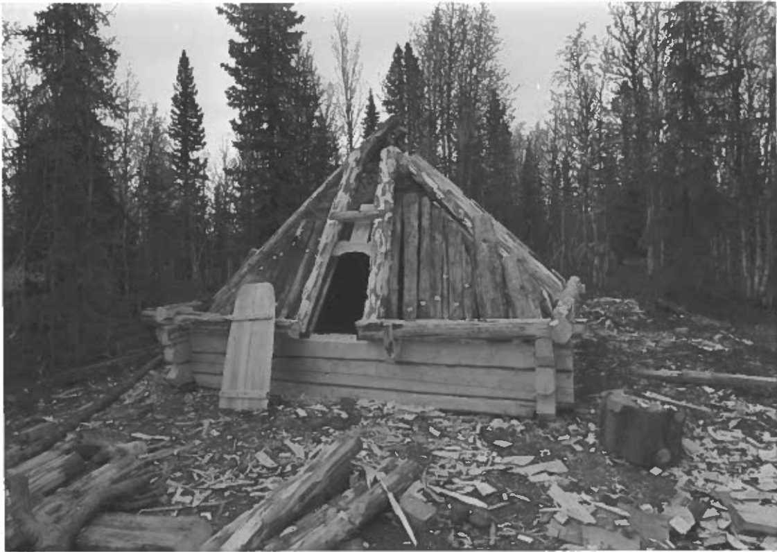
Bild 20 Skålka, kåta, läggning av näver och yttertak. Foto fr SSV av L. Liedgren, 1999.
