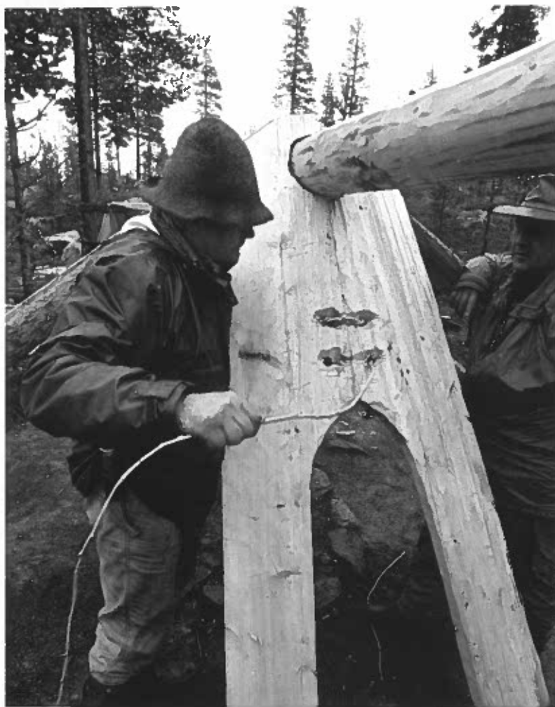
Bild 19 Suolojaurekåtan, montering av dörrhålsbrädor med hjälp av vridna vidjor av björk. Foto L. Liedgren, 1998.
