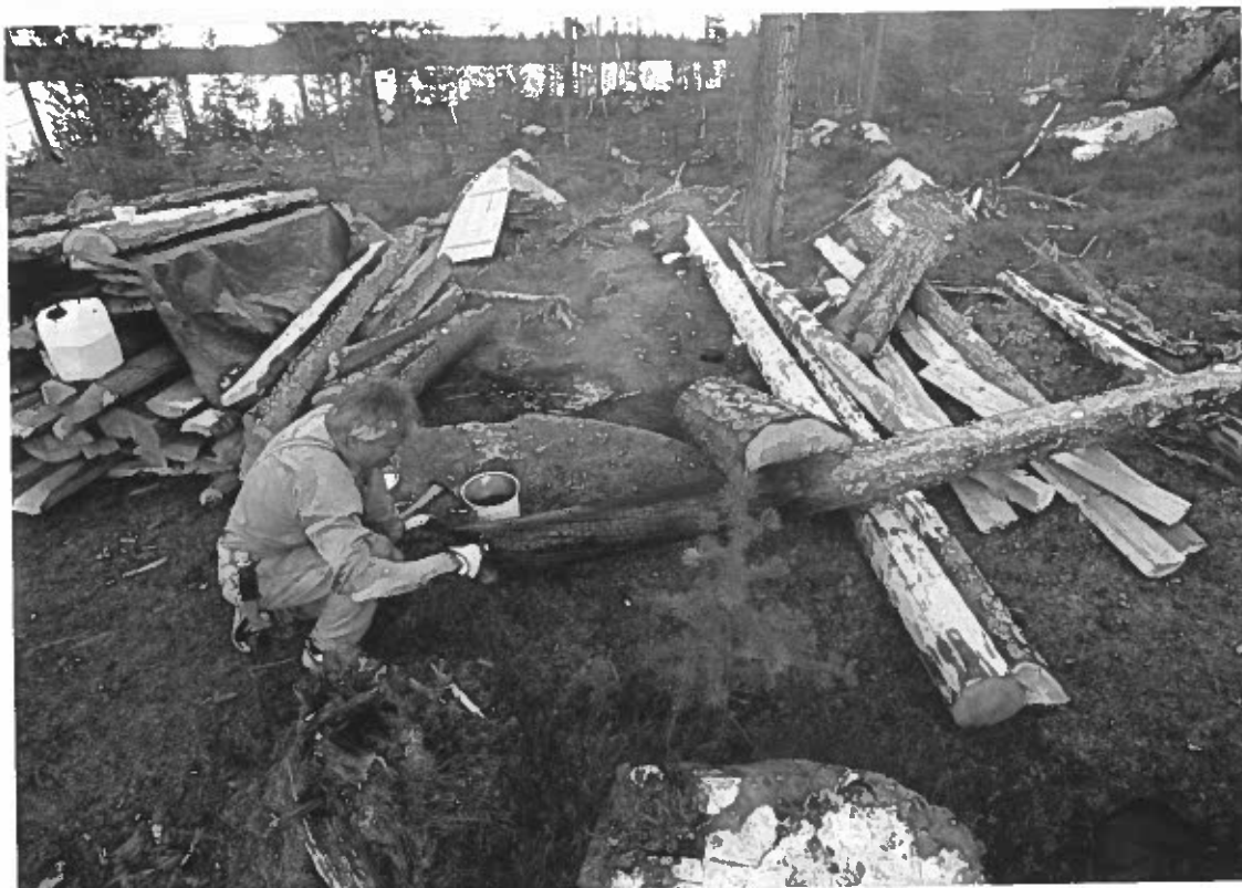
Bild 15 Suolojarekåtan, kolning och tjärning av nederdel av åsbärande stolpe. Foto L. Liedgren, 1998.
