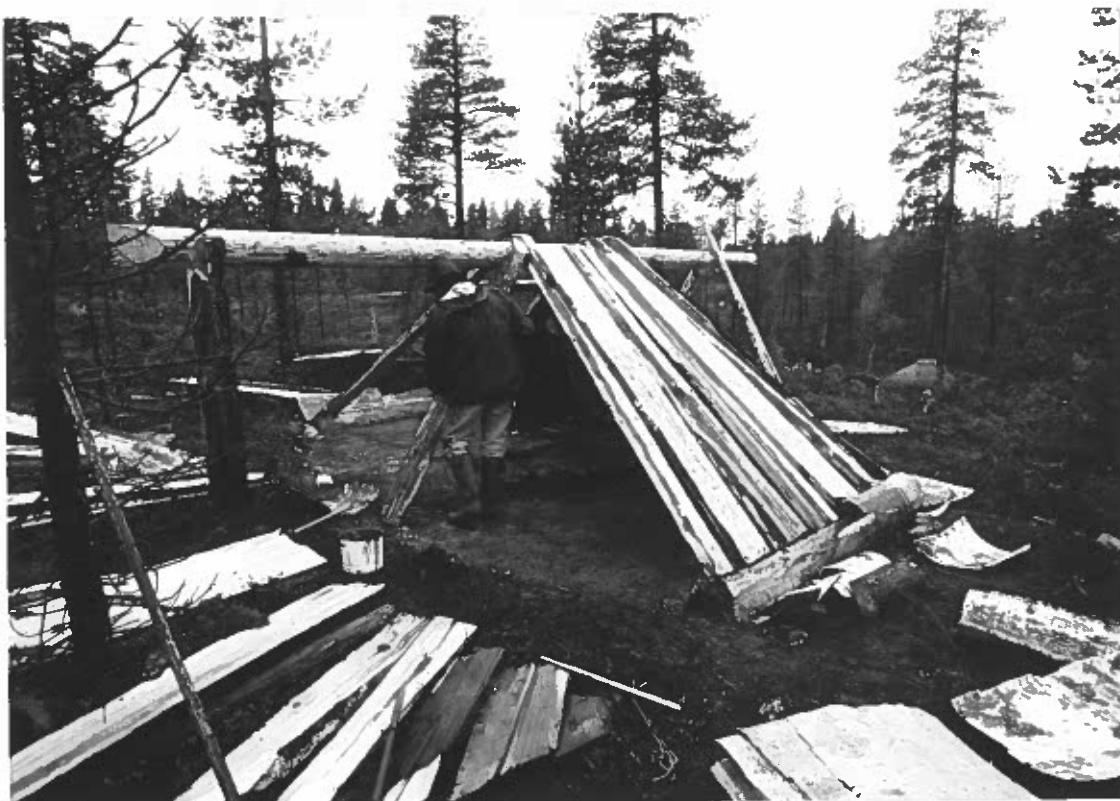
Bild 21 Suolojaurekåtan, uppmontering av innertak, fr Ö. Foto L. Liedgren, 1998.
