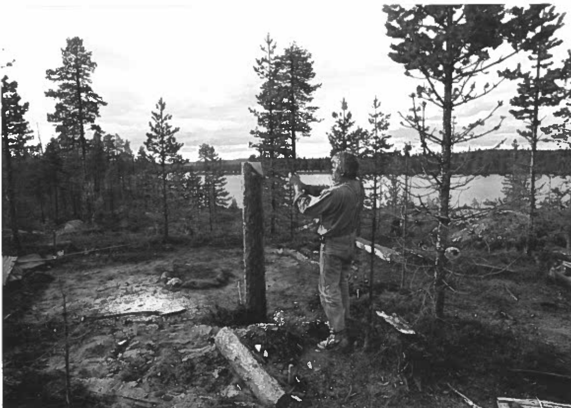
Bild 17 Suolojaurekåtan, huggning av V-format urtag i åsbärande stolpe. Foto av L. Liedgren, 1998.
