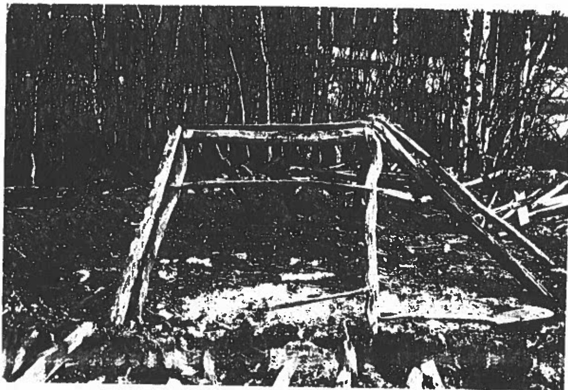
Bild 16 Getkåta i Vuoulak, bågstångskonstruktion. Foto fr SV av L. Liedgren, 1996.
