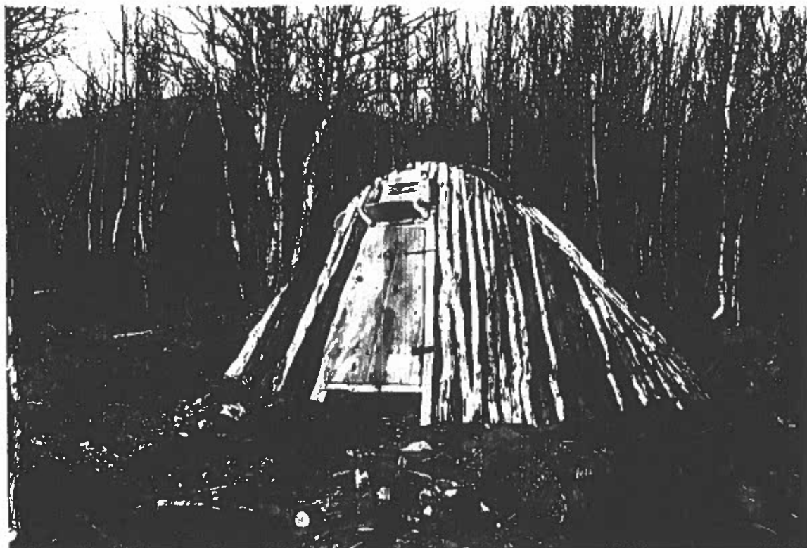
Bild 20 Getkåta i Vuoulak, renoverad, resvirke, dörr. Foto av L. Liedgren, fr SÖ, 1996.
