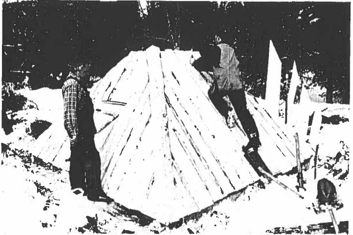
Bild 8 Aistop-kåtan, spikning av tak. Foto av L. Liedgren, 1996.
