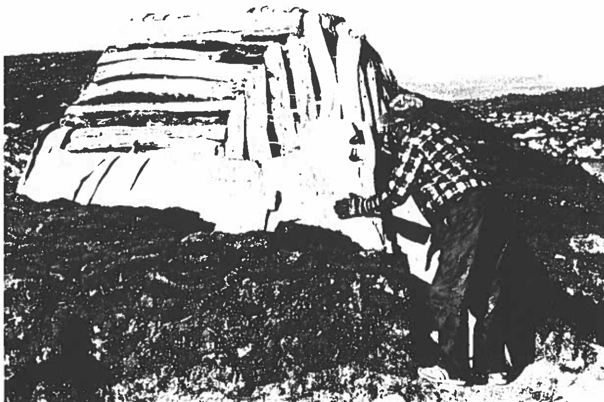
Bild 2 Tjäurakåtan, läggning av näver samt torv. Foto av L. Liedgren, 1995.
