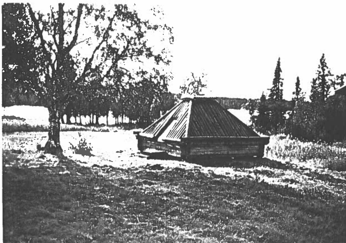
Bild 9. Renoverad kaita (nr 1). Foto av L. Liedgren, fr öster, 1994.
