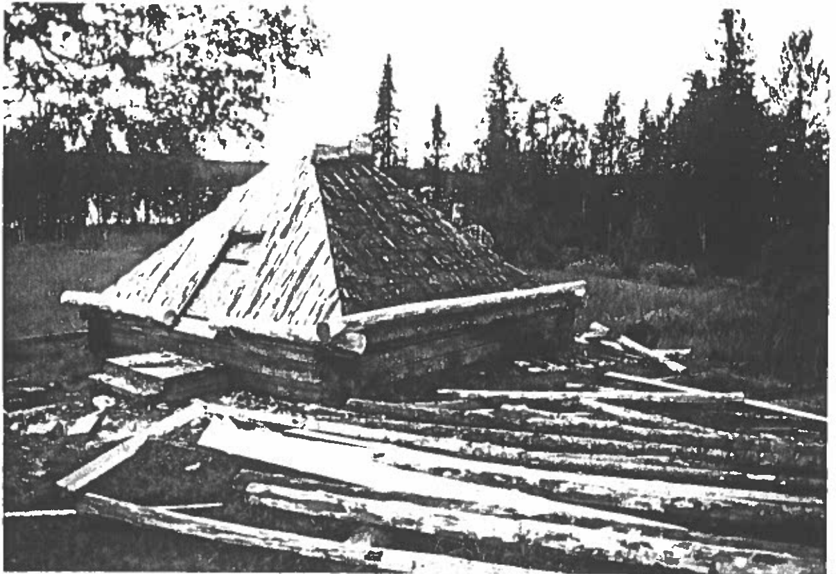
Bild 8. Kåtan (nr 1) under renovering. Foto av L. Liedgren, fr öster, 1994.
