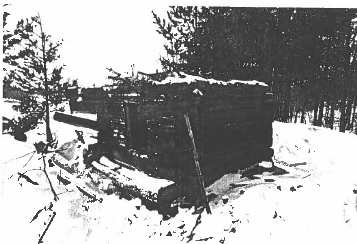
Bild 4. Stolpbod nr 5, före renovering. Tak helt inrasat samt underrede nedruttnat. Foto av L. Liedgren, fr öster, 1994.
